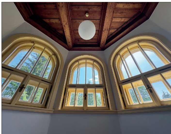
Interiér po rekonstrukci
