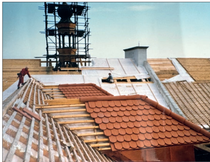
Rekonstrukce střechy Nového Adalbertina
