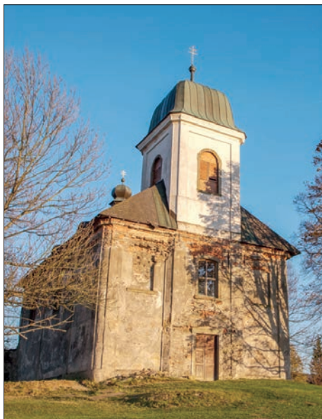
Kostel sv. Matouše prochází obnovou
