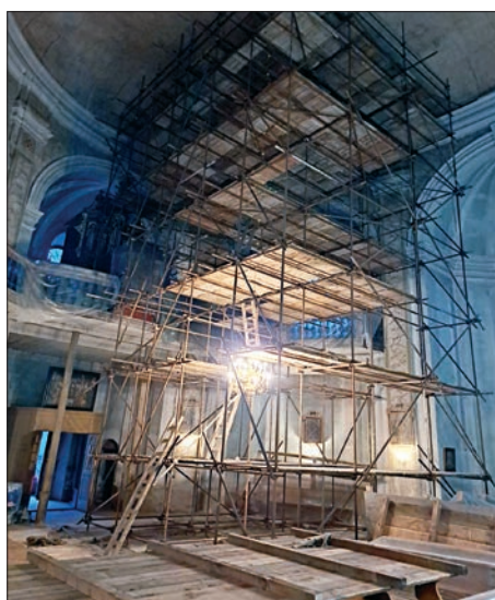
Práce na obnově vnitřního stropu kostela sv. Barbory v Otovicích
