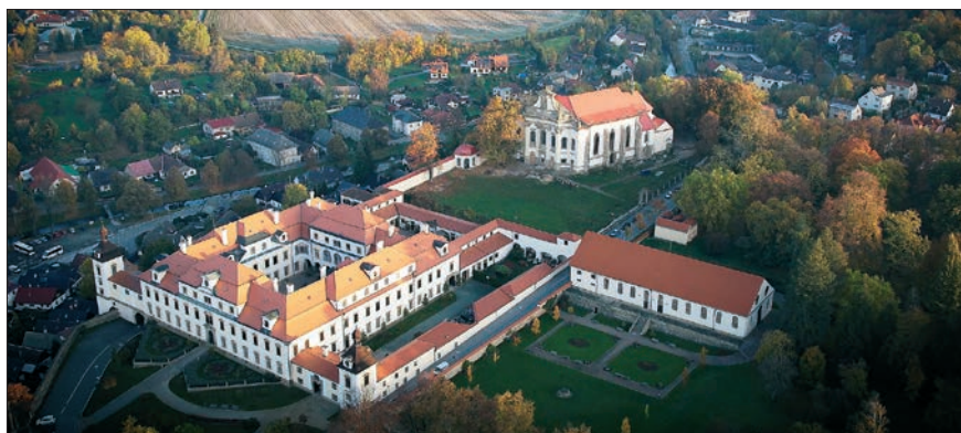
( Zámecký areál prošel během 30 let rozsáhlými opravami
