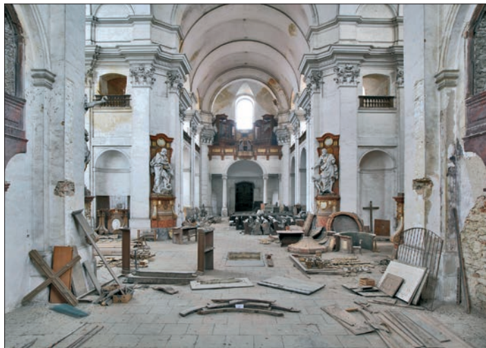
Stav před rekonstrukcí r. 2010
