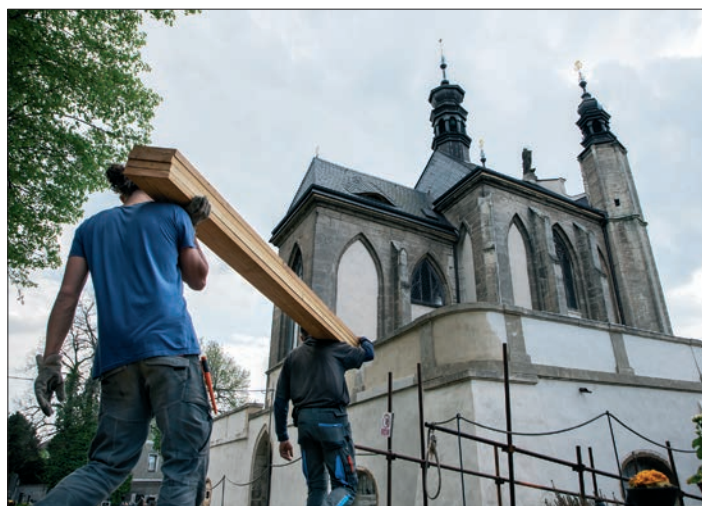
◀ Tesaři transportují materiál pro stavbu nové dřevěné konstrukce pyramidy
