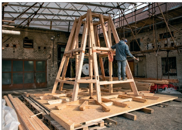
☛ Tesař při výrobě a sestavování nové dřevěné konstrukce pyramidy ve zkušební montážní hale
