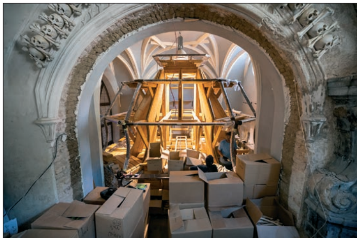
☛ Pohled do otevřeného klenebního pole, restaurátor Tomáš Král a jeho tým pracuje na stavbě prvního patra pyramidy. V popředí jsou složeny transportní krabice s kosterním materiálem.
