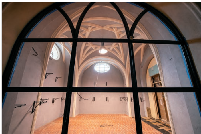
☛ Pohled na nově opravený interiér klenebního pole
