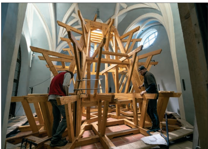
☛ Tesaři při sestavování nové dřevěné konstrukce pyramidy v prostoru klenebního pole
