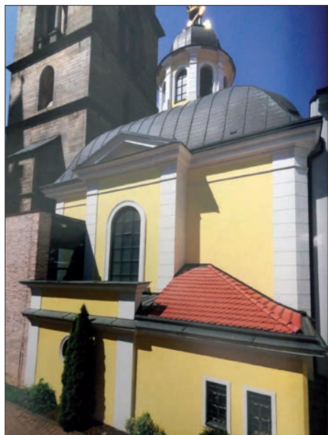
◀ S opravou kaple se začalo v r. 1995, její stav byl havarijní
