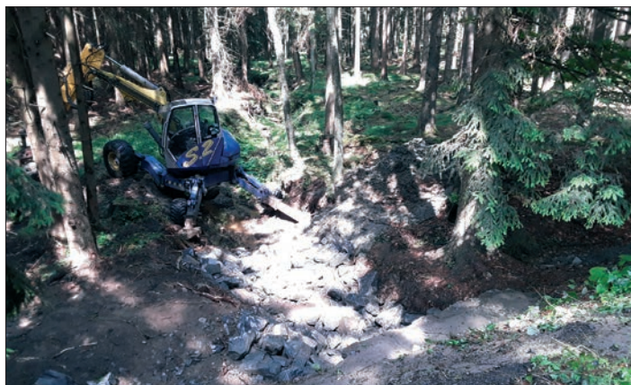
☞ Oprava propustky Košínov
