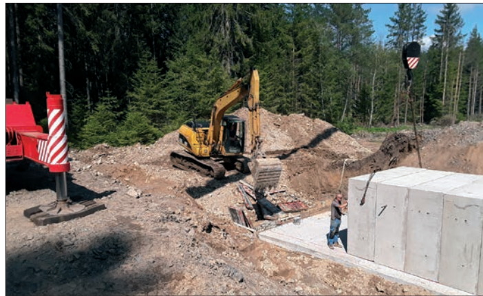
Budování odtoku bezpečnostního přelivu na hrázi Malého Černého
