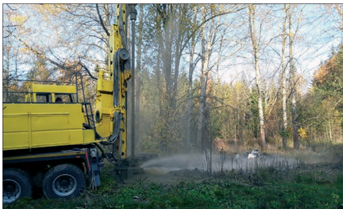
☞ Budování nového vrtu Vortová
