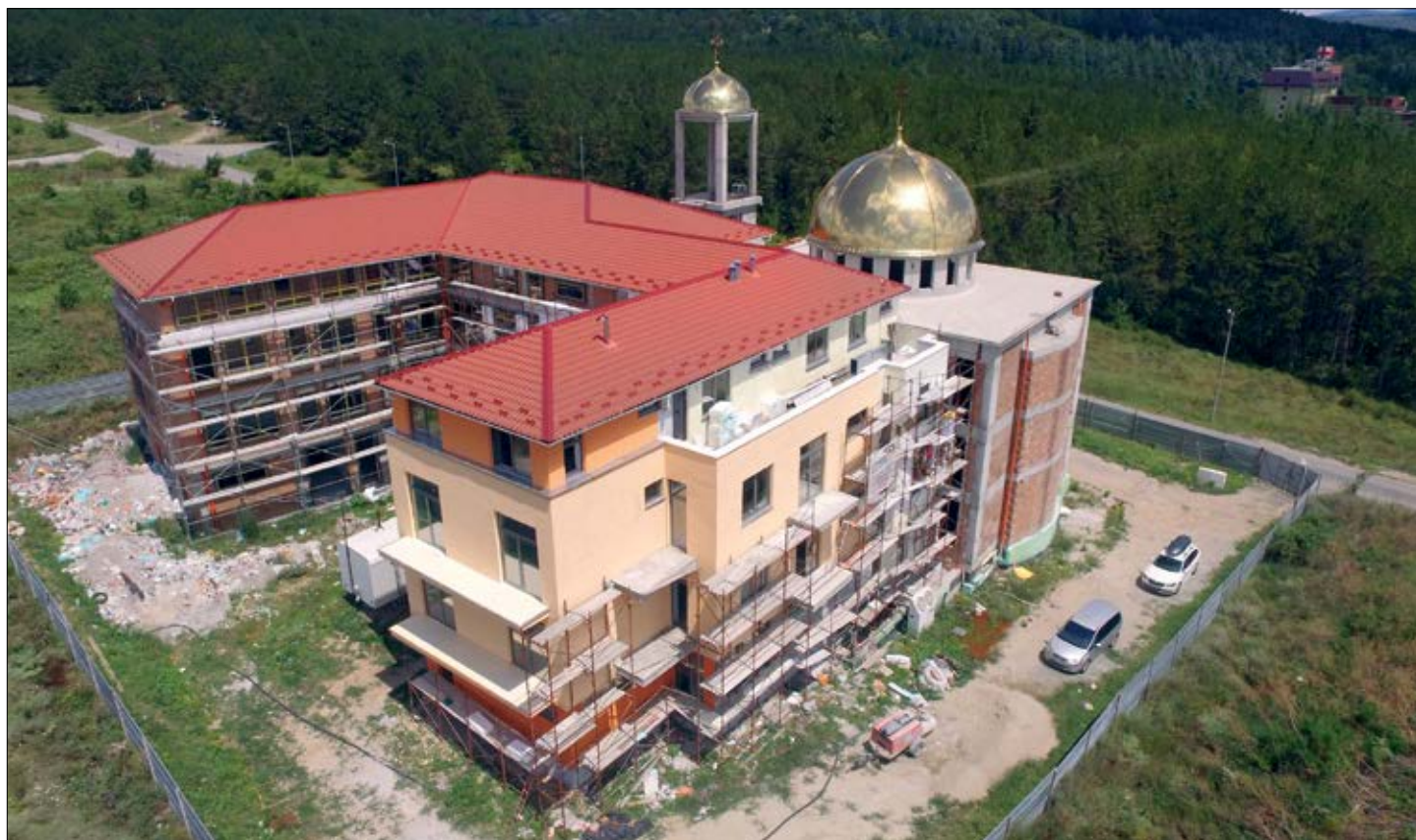
(Aktuální stav stavby nového kláštera
