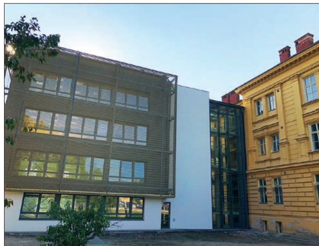
◀ Moderní přístavba u současného Biskupského gymnázia vznikla přestavbou tzv. funkcionalistické Kostky
