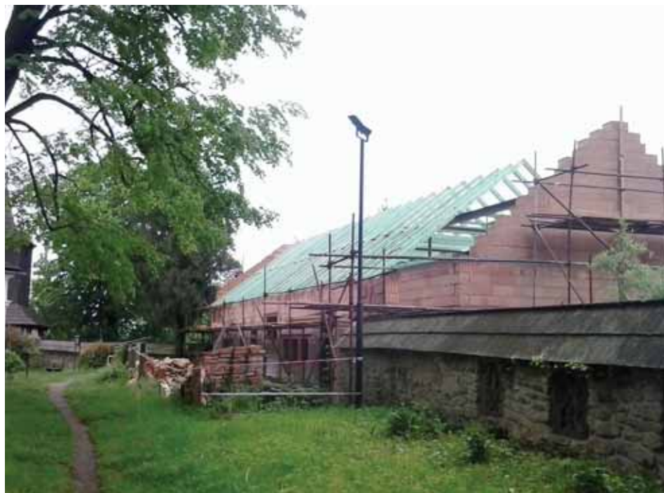
Rekonstrukce zázemí v České Třebové
