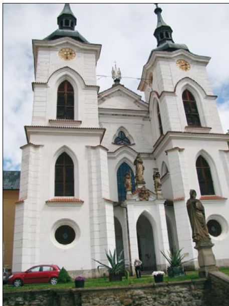
Ⓜ Klášterní kostel v Želivu ...
