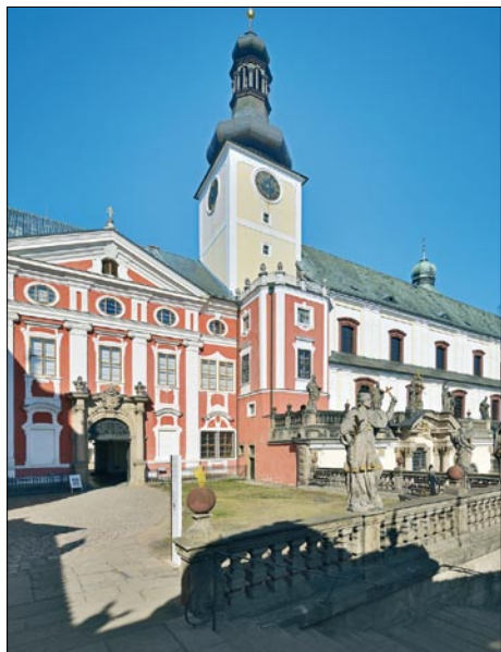
◀ Opravené průčelí bylo počátkem
