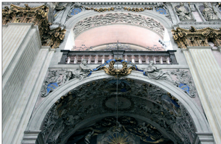
◀ Za štukovým věncem nad kaplí sv. Kříže se ukrývala...
