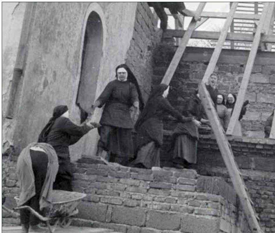
(E. P. při práci na opravě kláštera Hoješíně
