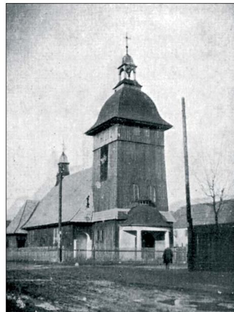
Kostel v krakovské čtvrti Debniki postavený z choceňského kostela barákové kolonie
