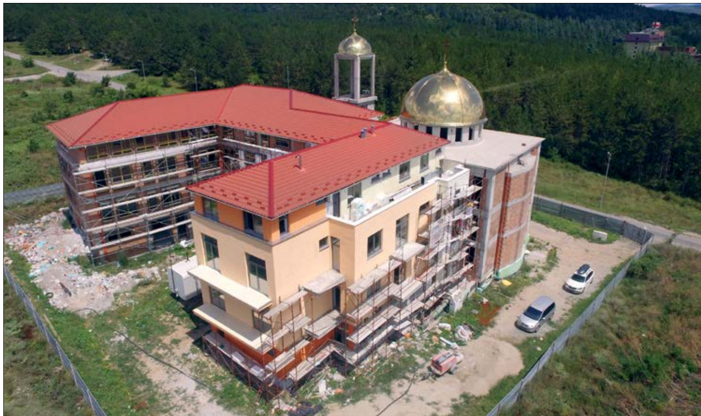
(Aktuální stav stavby nového kláštera
