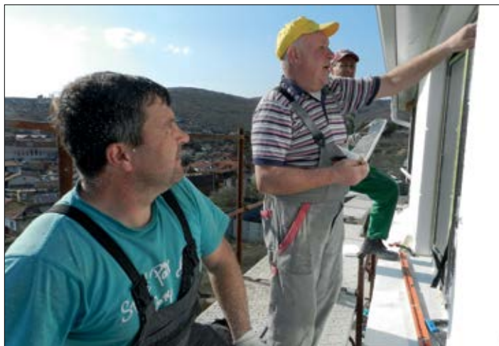
Brigádníci z Čech staví kostel v bulharské Staré Zagoře
