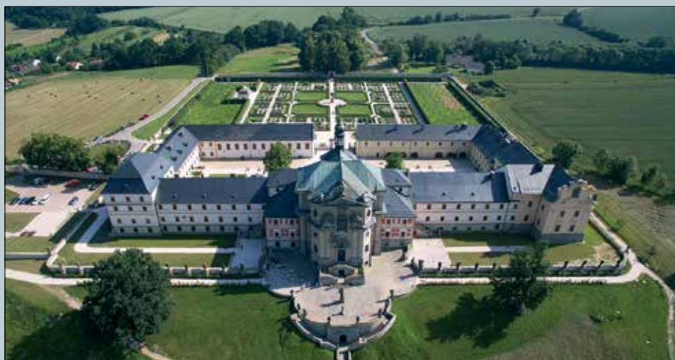
◀ Hospital Kuks po rekonstrukci
