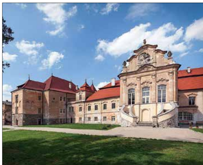
( Pohled na opatský dům v areálu kláštera
